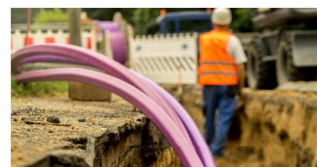
12–14 bar: wdmuchiwanie kabli i wiercenie
